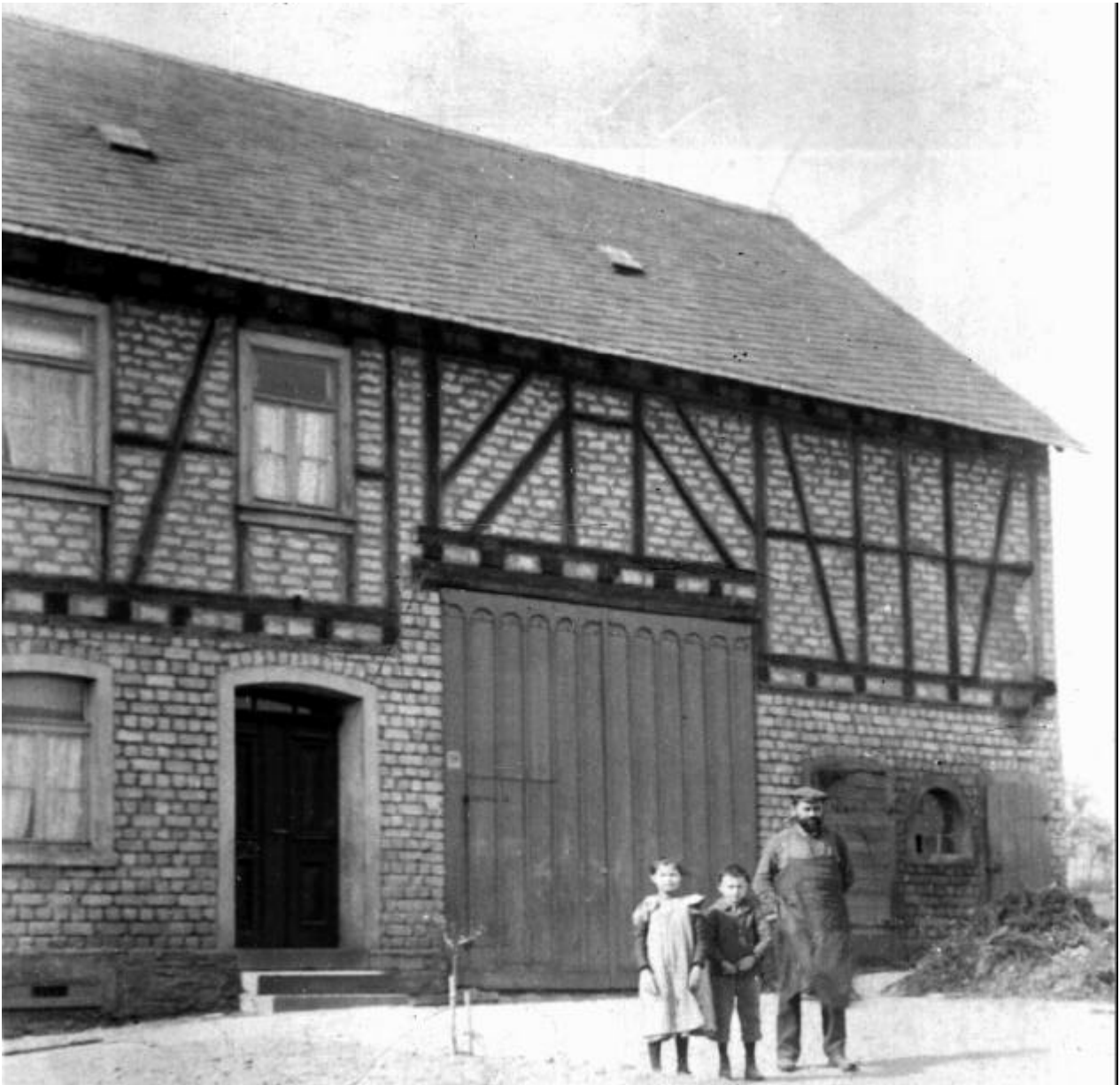
Abbildung 30 - Haus Wilhelm Feil (ca. 1909 mit Jakob Feil II)
